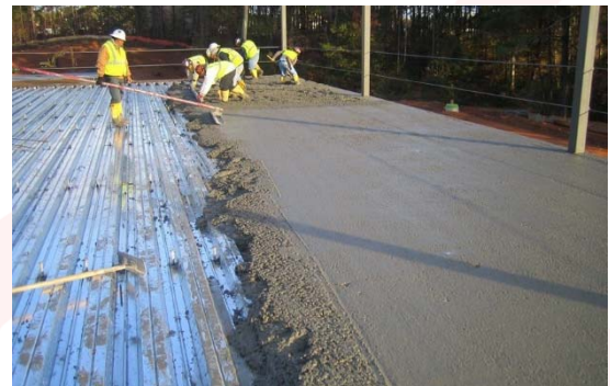
Cubierta de acero compuesto
